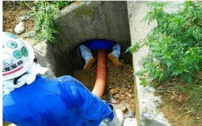
☆道路下の土中を横切るフェーム管には、土砂が堆積し、少しの水も流れなかったが、高圧洗浄車により土砂を掻き出し、強力吸引車でその土砂を吸引することにより、以前の状態へと復旧することが出来ました☆
